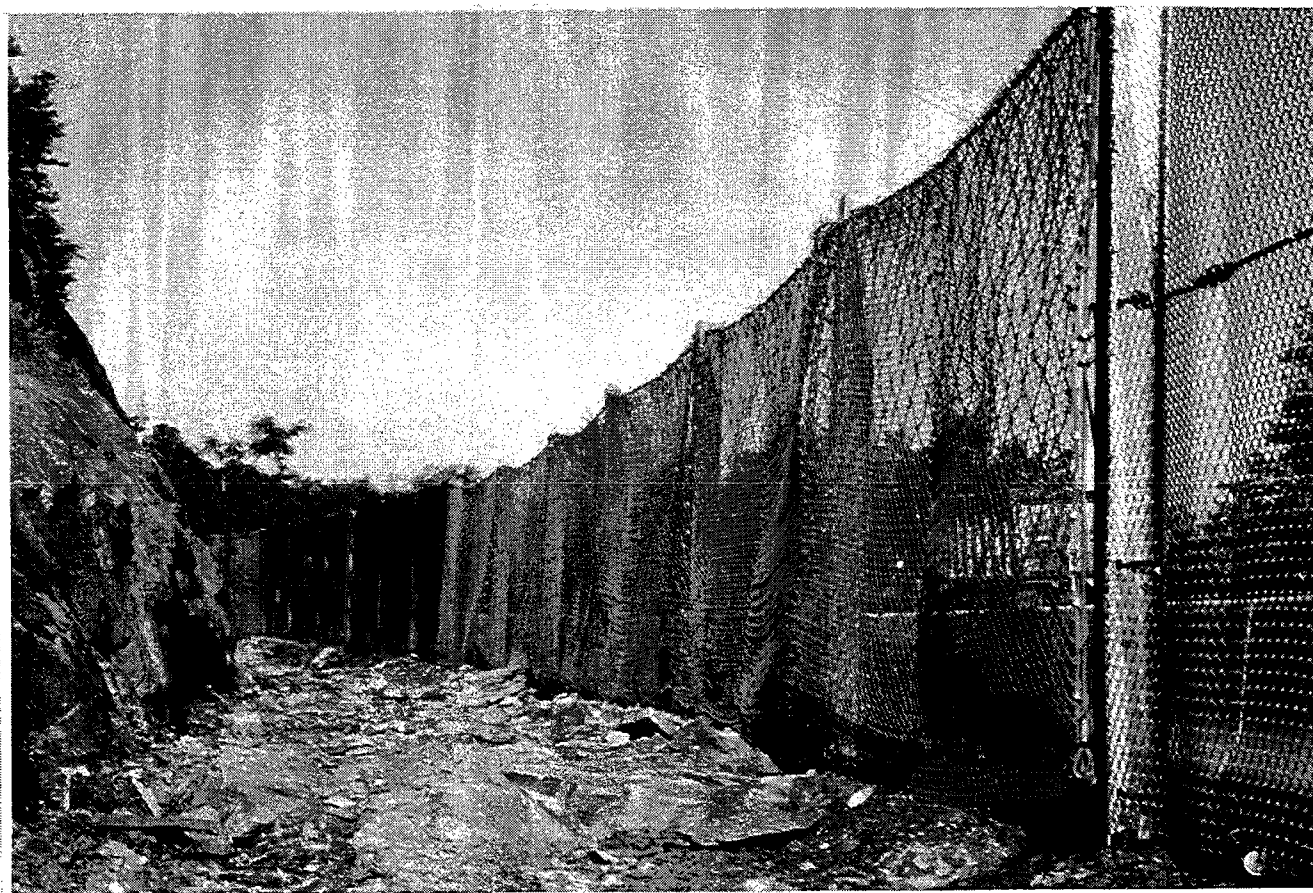
Pennsylvania DOT - S. R. 924 Retro-fitted Nets
